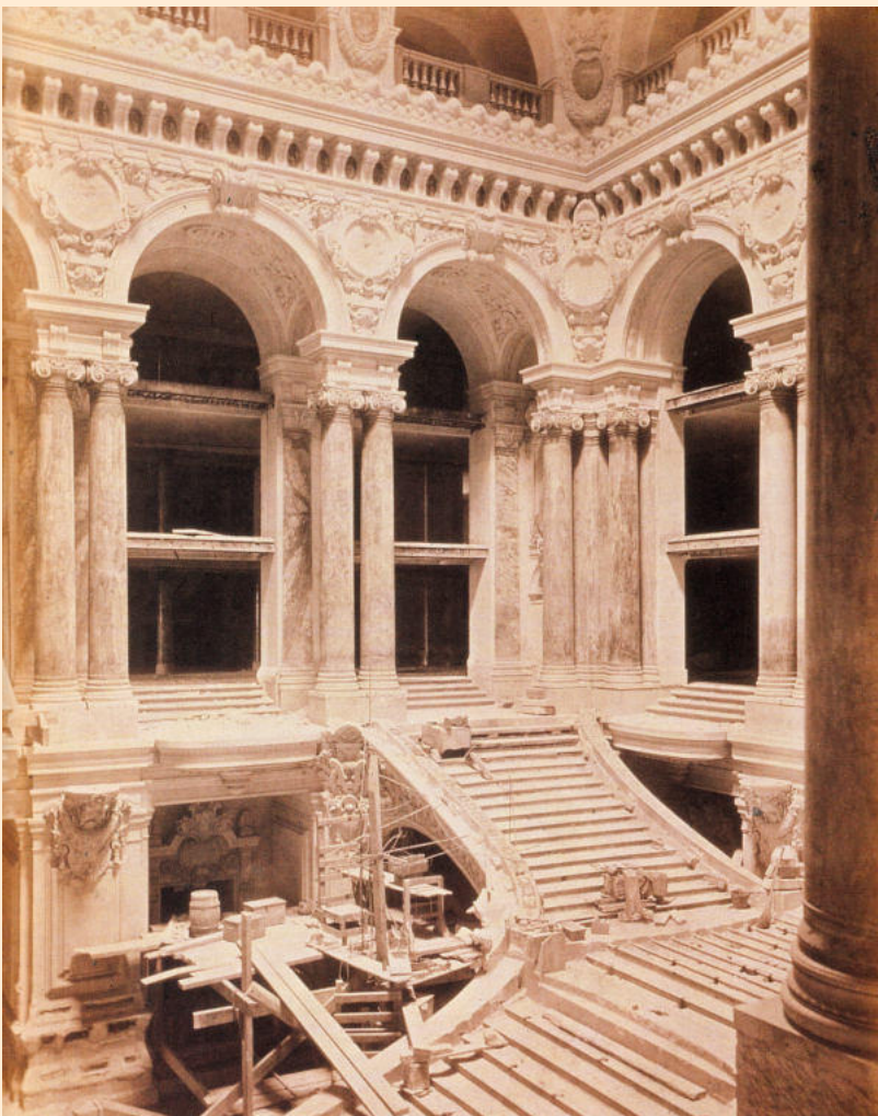
Baustelle, durch den Krieg fehlte es an Stuckateuren.
